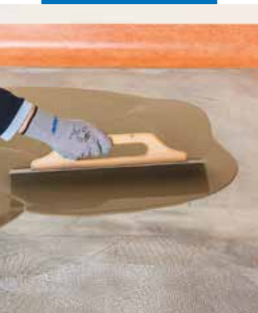
Stesura di Ultraplan Fast Track con spatola metallica
